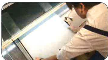
ショーケースの床板をはずします。
