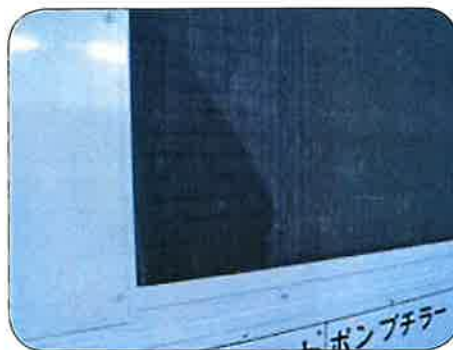
熱交換器の油のにじみ
