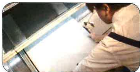
床板を外します
