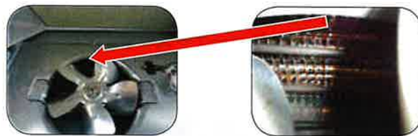
ファンの隙間から熱交換器の油のにじみ確認
